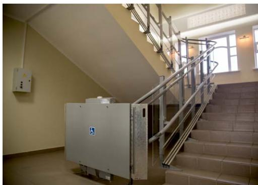
Фото 3, 4, 5. Универсальный подъемник открытого типа, предназначенный для вертикального подъема и спуска посетителей с ограниченными возможностями здоровья. Структурное подразделение ГЦНТ Культурно-исторический центр.
